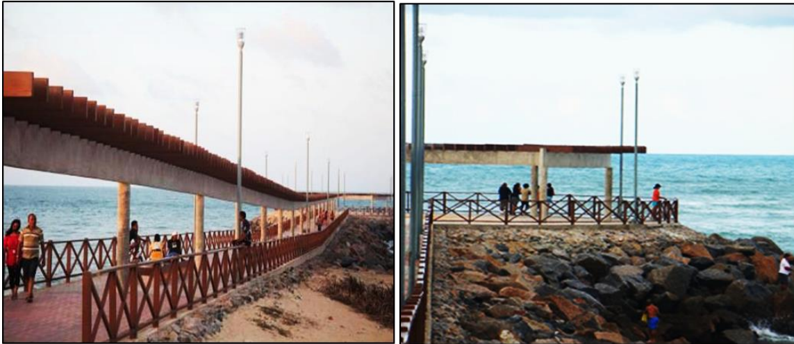
Figura 2 – Espigão urbanizado, mirante Rosa dos Ventos.
